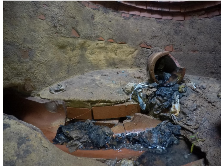
Brick Manhole Bottom
